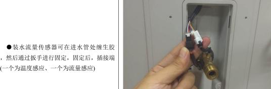
带,然后通过扳手进行固定,固定后,插接端 子(一个为温度感应、一个为流量感应)
